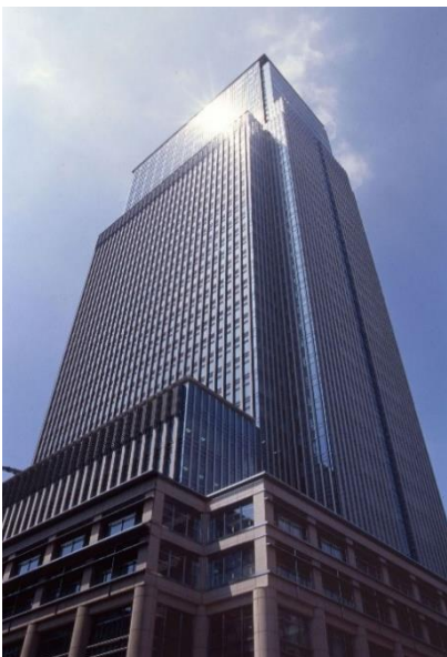
日本橋三井タワー
