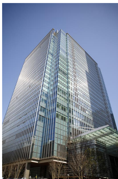
日本橋室町三井タワー
