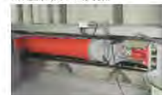
ロック機構付オイルダンパー（参考写真）
