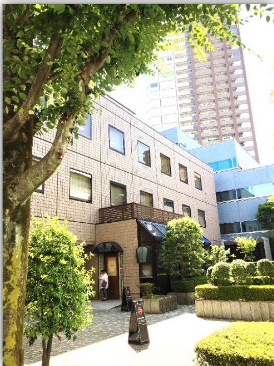
北側エントランス外観
