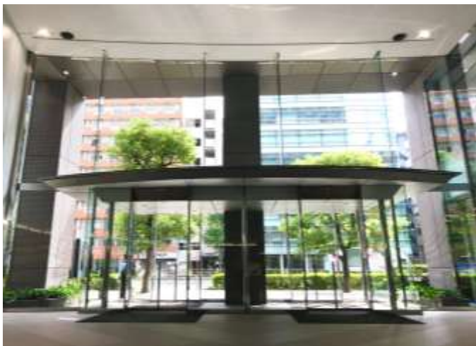
エントランスホール内部②
