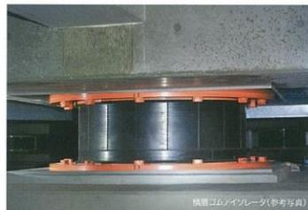
積層ゴムアイソレータ・オイルダンパーなど、地下1階床下に配された免震部材による免震層が、地震による振動エネルギーを吸収し建物の揺れを軽減、構造体の損傷を抑制し、大地震発生後の建物の継続使用を可能とします。
